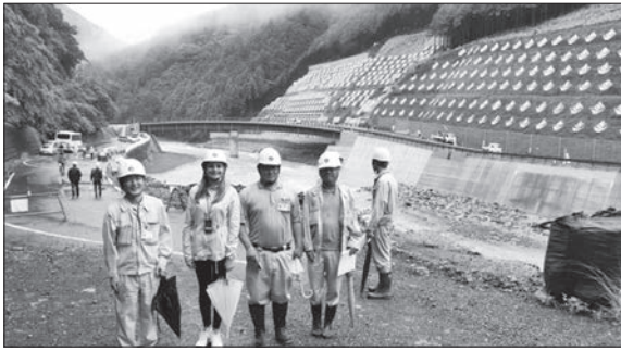
Слика 4. Санација клизишта у долини реке Кумано Photo 4: Landslide sanation in the valley of Kumano River
